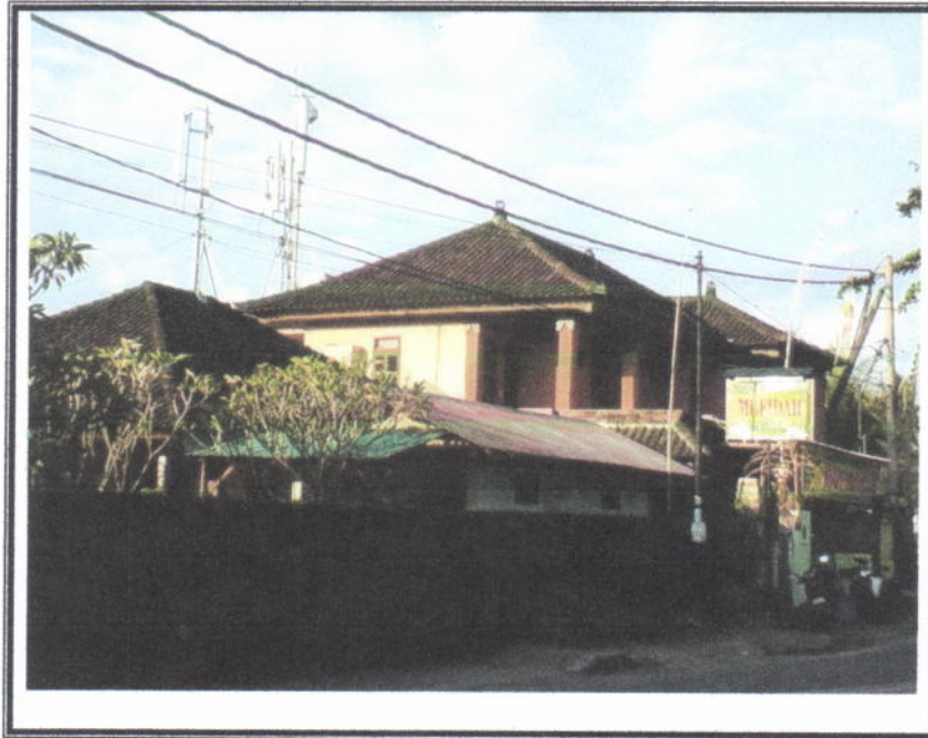
Contoh Pemasangan antenna di lokasi Roof Top
