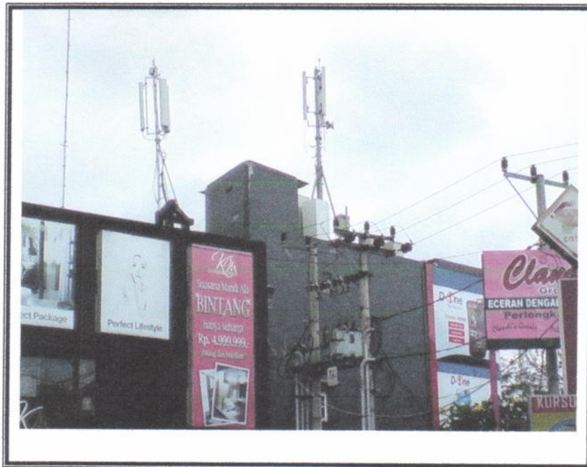
Contoh Pemasangan antenna di lokasi Roof Top
