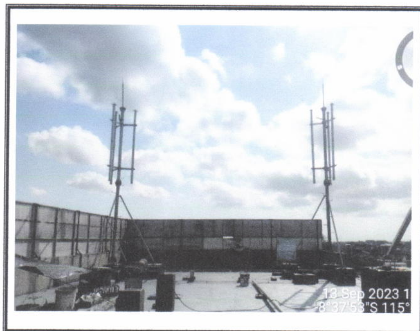
Contoh Pemasangan antenna di lokasi Roof Top
