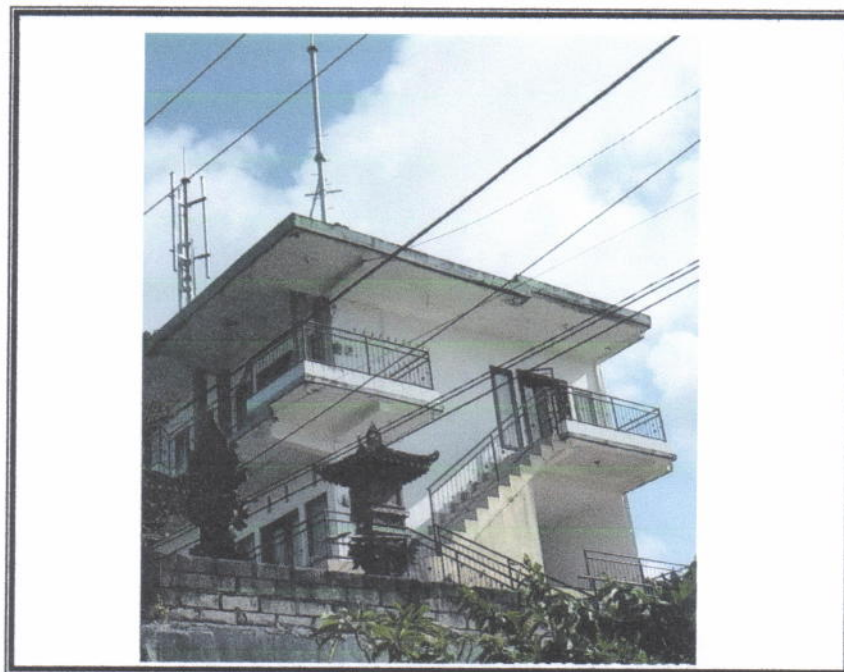
Contoh Pemasangan antenna di lokasi Roof Top
