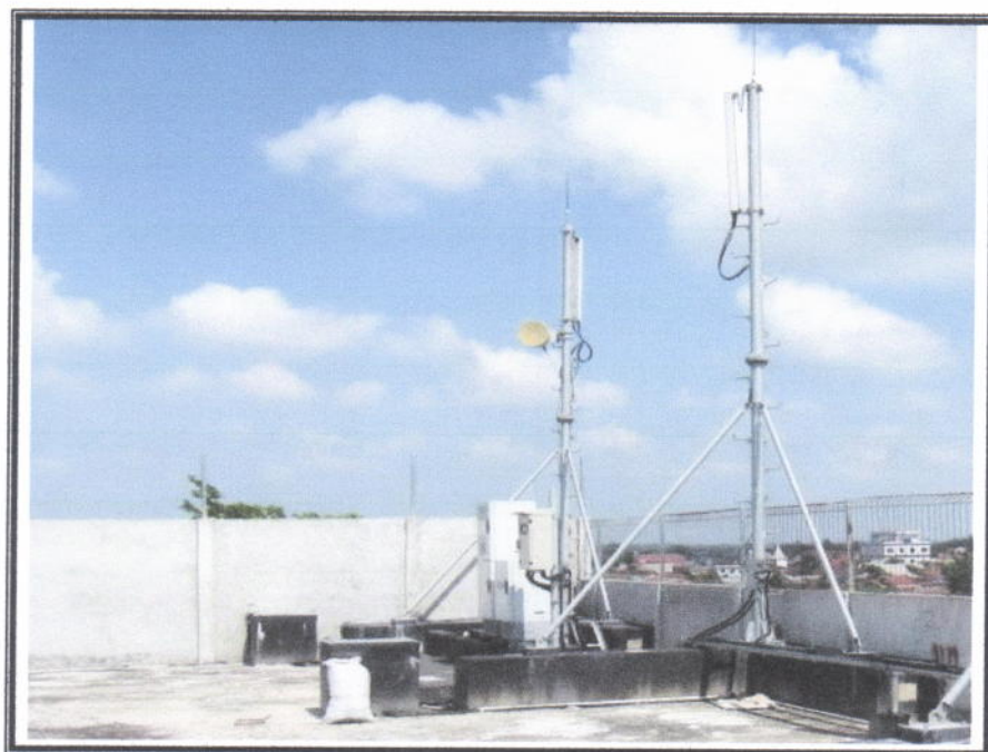
Contoh penempatan perangkat, pole 6m dan antenna
